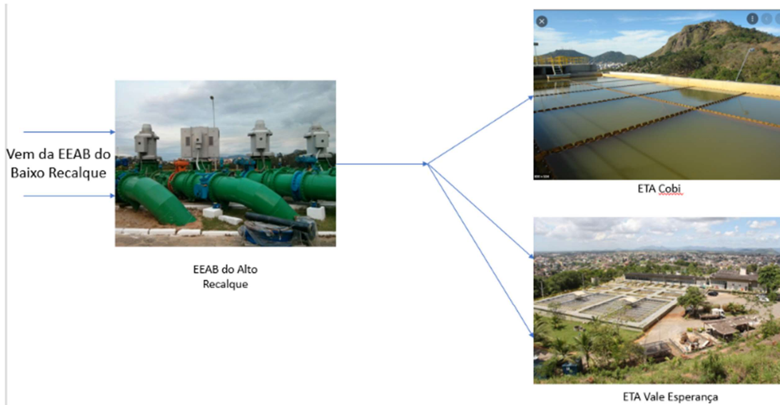
Figura 19 - Sistema do Rio Jucu - EEAB Alto Recalque para a ETA Vale Esperança e ETA Cobi (Fluxo Hidráulico)
