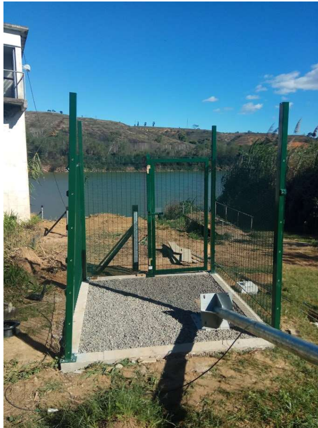
Figura 12: Exemplo de gradil de segurança montado em campo.
